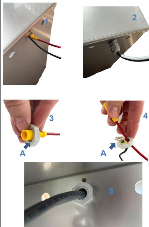
Placer le caisson contre le mât et insérer le presse-étoupe dans l'ouverture prévue
