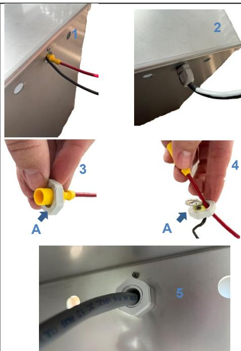
Placer le caisson contre le mat et insérer le presse-étoupe dans l'ouverture prévue
