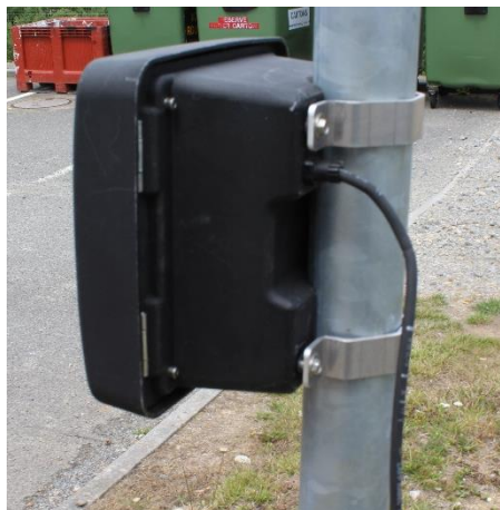
Esempio di installazione su palo Diam. 60
