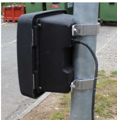
Exemple d'installation sur mât Diam. 60
